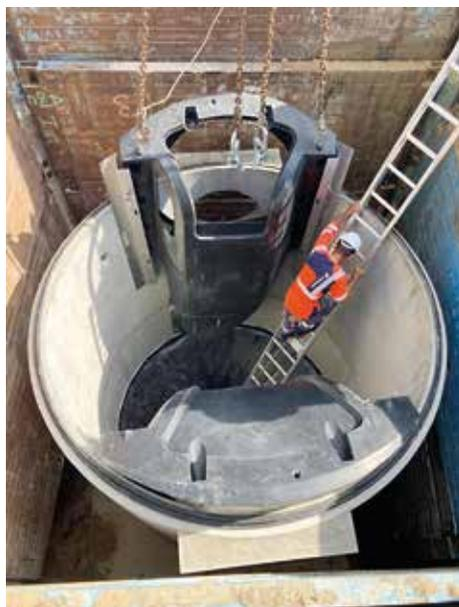
Pose du vortex en 2023: dispositif de gestion et purification des eaux pluviales, installé sous le parking du Cap Nord
