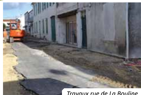
Travaux rue de La Bouline
