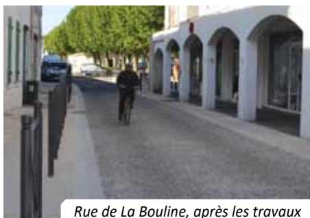
Rue de La Bouline, après les travaux
