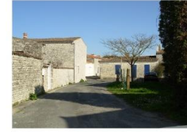
Desserte du quartier. Cas d'une voirie en sens unique et intégration d'une bande piétons/cycles
