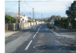
Desserte du quartier. Cas d'une voirie simple intégrant les déplacements doux (voirie double sens)
