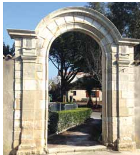
Mise en sécurité du porche, rue Pierre Loti
