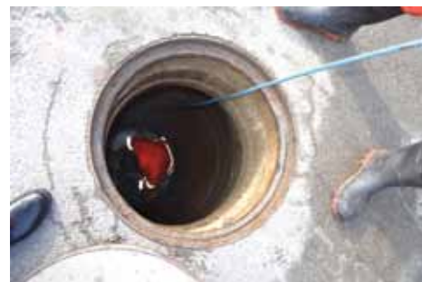
Rue des Garnaudières, les travaux d'assainissement se poursuivent jusqu'en mars, ensuite la voirie se terminera début juin.
